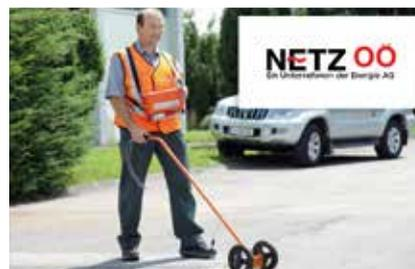
Im Zuge der Wartung des Gasnetzes wird die Leitungsstraße mit einem Gasspürgerät abgegangen und geprüft.
